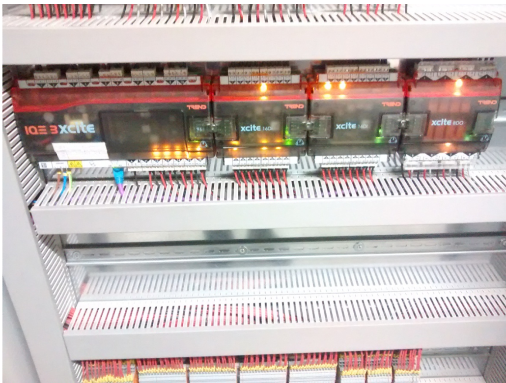
Controlador y módulos de ampliación tipo en cuadro de control
